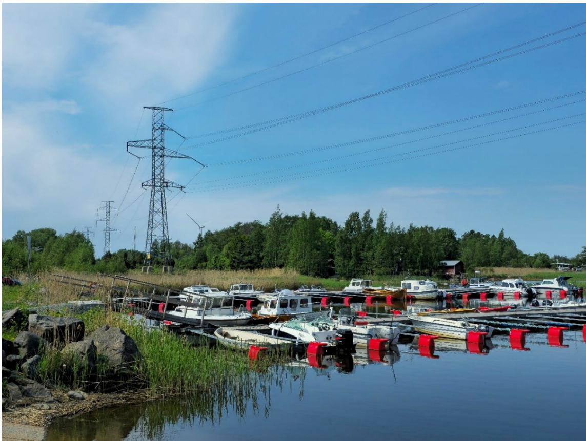
Kuva 8-1. Olemassa olevat voimajohtolinjat Rähänsuntista kuvattuna luoteeseen (Kuva Suomen Hyötytuuli Oy).
